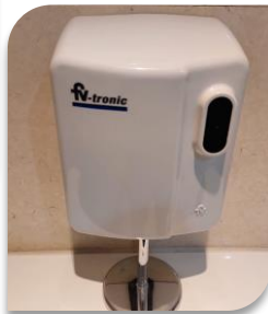
Sensores de Proximidad en Lavatorios y Sanitarios para controlar el uso del Agua.
